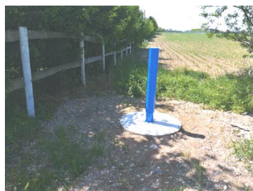
Fotografija izvedbe pizometra T8
